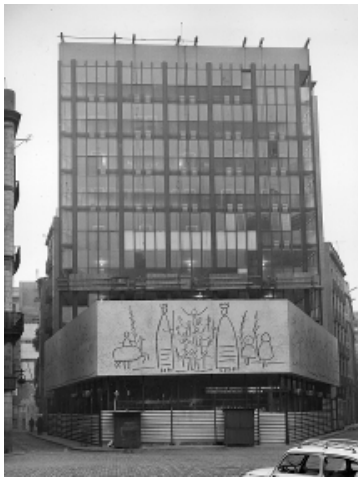
Esgrafiats del cos central amb l'edifici gairebé acabat
